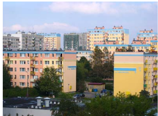
Rys. 14. Osiedle „Jaroty” w Olsztynie – budynki po termomodernizacji
