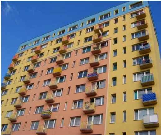
Rys. 13. Osiedle „Jaroty” w Olsztynie – budynek po termomodernizacji.
