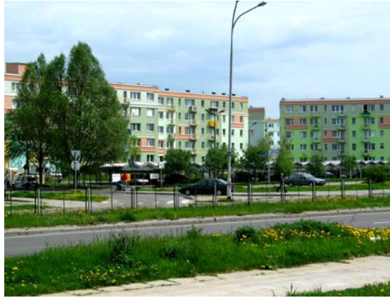
Rys. 12. Osiedle „Pieczewo” w Olsztynie – budynki po termomodernizacji.
